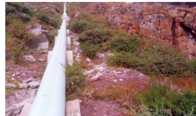
Figura 2. Tubería que conduce el agua para generar la corriente eléctrica
